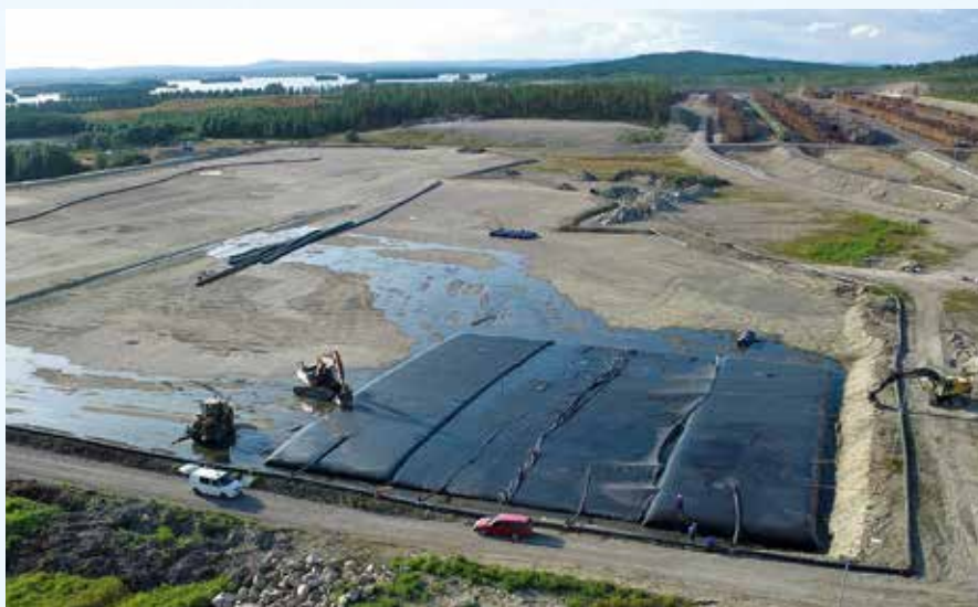
Neljä geotuubia levitetty kentälle ilmakuvana.
